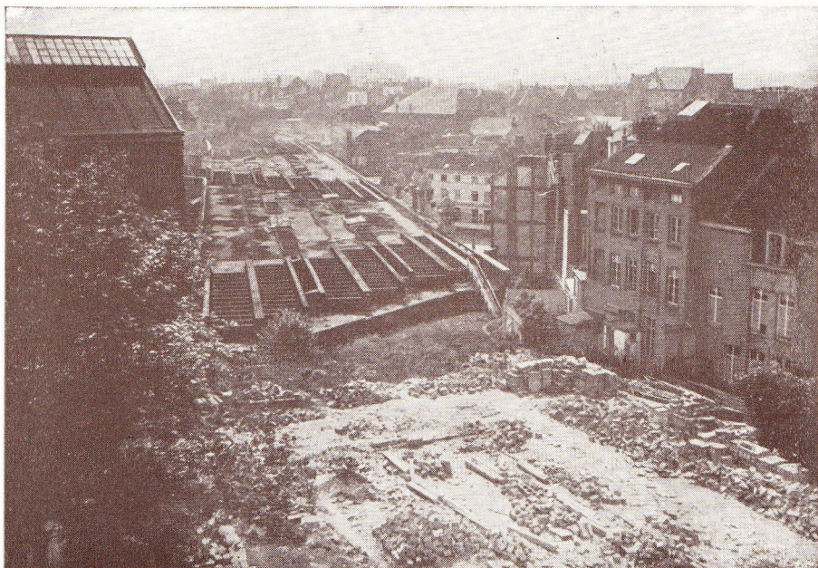
Fig. 214. La Jonction ferrée Nord-Midi, vue des travaux d'établissement de la voie nouvelle. (après la guerre). Cliché prêté par le T. C. B.
